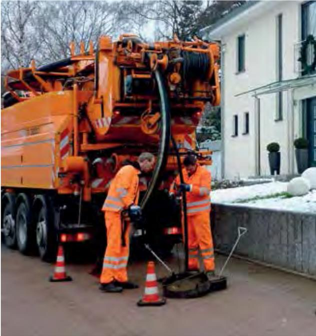
**Die Dichtheitsprüfung privater Abwasserleitungen ist in einigen Bundesländern bereits Pflicht**
