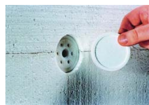
Abbildung 4-1 Mögliche Verarbeitung von WDVS -Dübelsystemen
