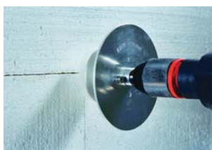
Abbildung 4-1 Mögliche Verarbeitung von WDVS -Dübelsystemen
